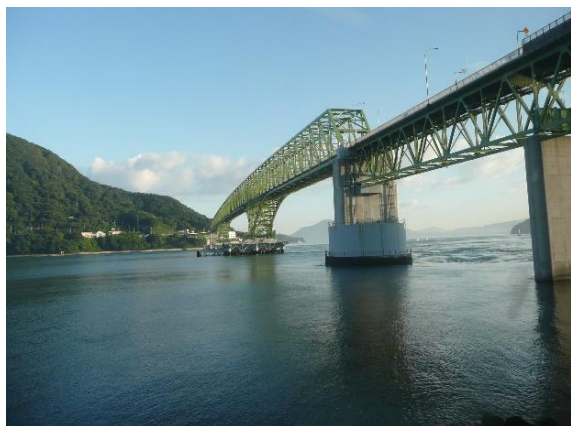
大島大橋（全長 1,020m）
